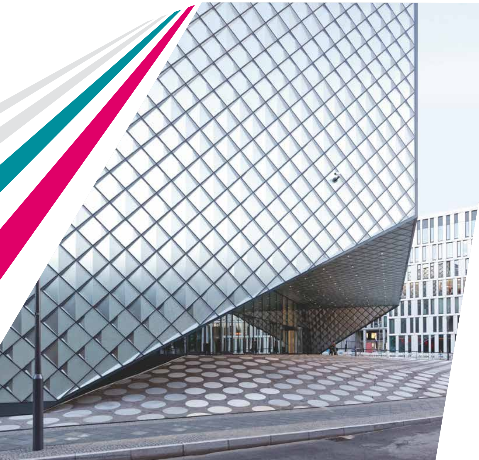
Anerkennung »Deutscher Fassadenpreis 2018 für VHF«: Futurium, Berlin Richter Musikowski Architekten PartGmbH, Berlin Foto: Richter Musikowski Architekten PartGmbH
